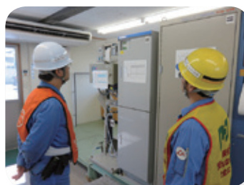
環境重点設備点検(星崎工場)
